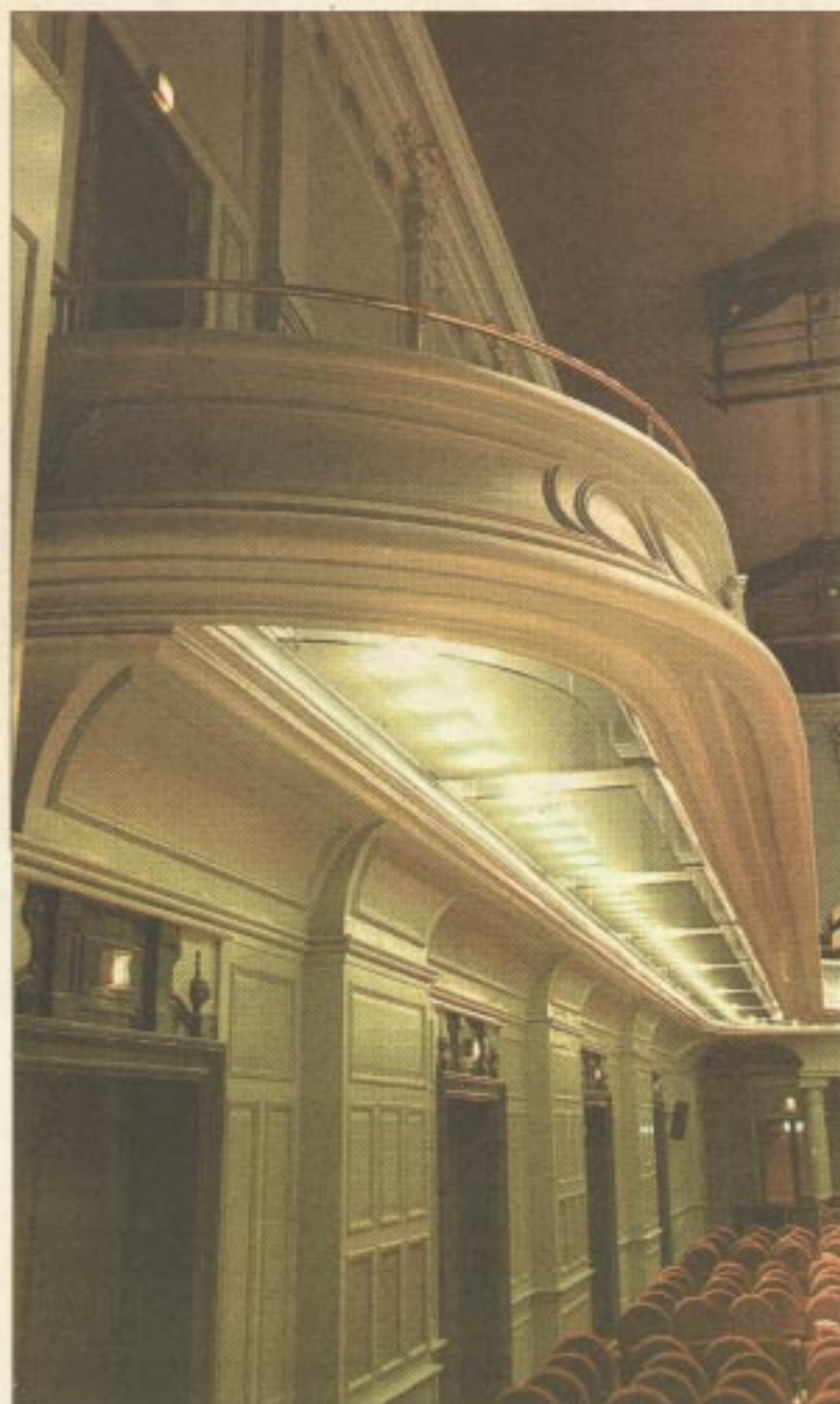
Het oude afgestompte balkon werd door Engelse specialisten van halfronde uitelenden voorzien.
